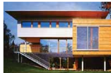
Passive house in Oberosterreich, Austria (2000). Source: IG Passivhaus Osterreich Innovative Passivhaus projekte.
